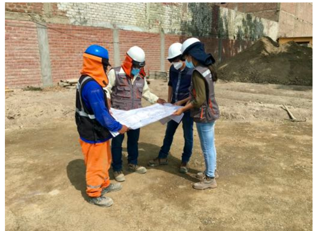
Diese Pläne lesen, verstehen und umsetzen ist nicht gerade einfach. Es ist eine für Peru sehr ungewöhnliche Bauweise.
