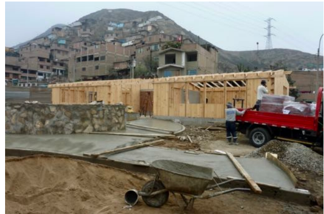
Das Gebäude, komplett aus Holz, ist aufgerichtet (2015)
