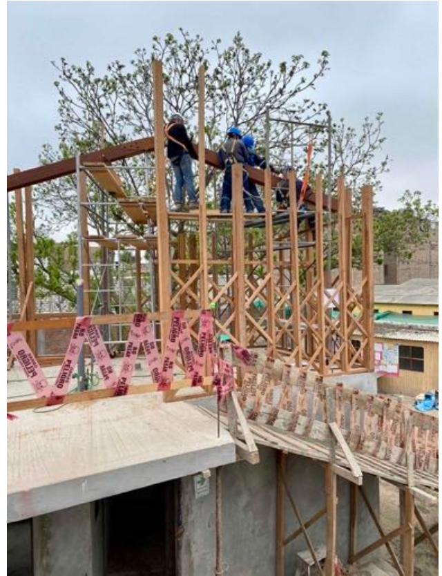
Das Obergeschoss wird komplett mit Holz-Lehmwänden und einer Dachkonstruktion aus Holz ausgeführt. Die Ständerkonstruktion wird noch mit einer Lehm-Grasmischung ausgefacht.
