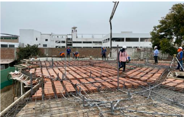
Auch die Erdgeschossdecke aus Tonhohlplatten und Beton ist erdbebensicher mit Stahl armiert.
