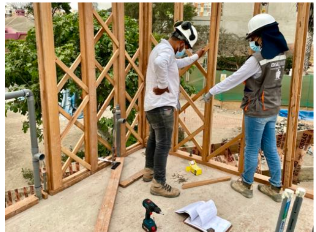
Auf jeder Baustelle müssen, von Gesetzes wegen ein bis zwei Ingenieur*innen den Bau begleiten. Hier sind es zwei Frauen die kontrollieren und Anweisungen erteilen.
