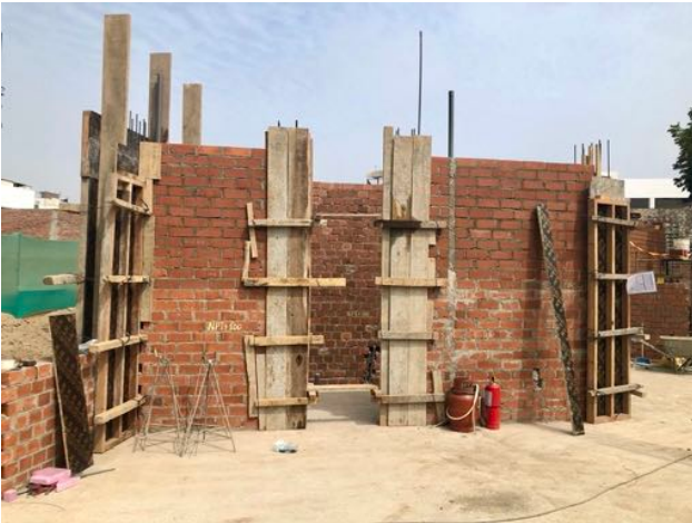
Auf der Bodenplatte werden Stützen und Mauern aufgerichtet.
